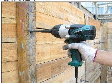
ソケットにスクリービットを挿入し、下穴に対してねじ込んでいく。スクリービットの六角ツバがH鋼面に接する程度でねじ込みを止める。
