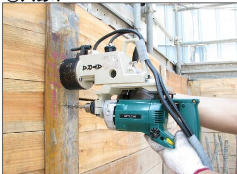
セパ墨の位置にドリルの刃先が合うようにマグネットを磁着させる。ドリルの電源をいれロックボタンを押し、ハンドルを回転させて12mm以上の下穴をあける。
